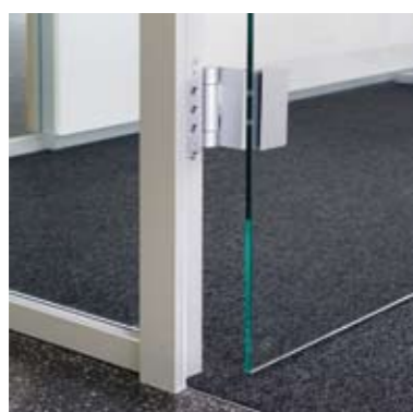
Element: Glas-Türelement fecoplan G8 Türzarge: Aluzarge 35/50T60 in Alu natur eloxiert Türblatt: Glas-Türblatt 8 mm ESG klar Prüfwert: R_{w,P} = 23 dB, optional 32 dB Oberteil: Verglasung fecoplan in Alu natur eloxiert Glaswand: Verglasung fecoplan in Alu natur eloxiert
